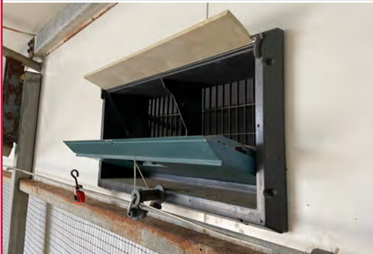
Figura 6.10 Ejemplo de una entrada de aire de buena calidad.
