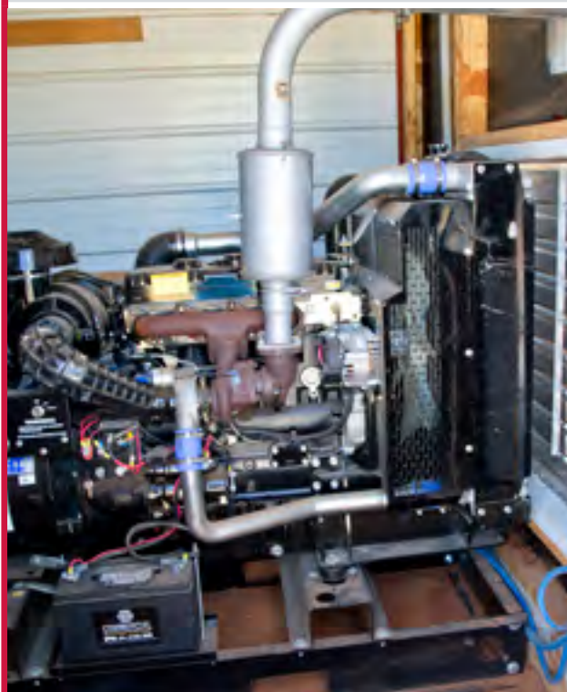
Figura 6.2 Ejemplo de un generador de reserva.
