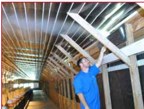
Figura 6.7: Uso de una prueba de humo para determinar si el flujo de aire y la presión de funcionamiento son correctos.
