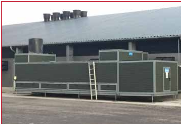
Figura 2.6: Ejemplo de un intercambiador de calor.
