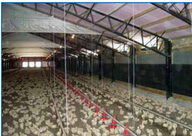
Рис. 6.10: Вид птичника при переходной вентиляции. Приточные форточки полностью открыты и осевые вентиляторы включены. Распределение птицы по птичнику указывает на комфортность поголовья.
