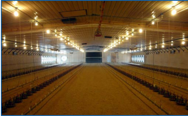
Figura 6.3: Esempio di capannoni a ventilazione forzata.
