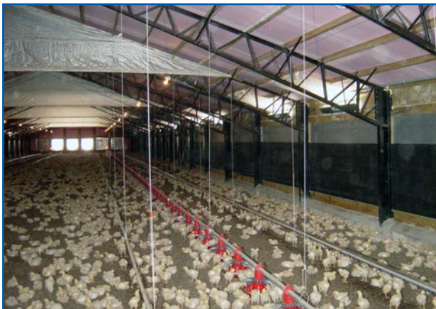
Figura 6.10: Vista interna con ventilazione di transizione in uso. Le finestrelle sono aperte e i ventilatori a tunnel in funzione. La distribuzione degli animali indica che le condizioni sono buone.
