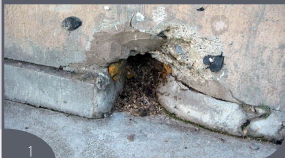
Scavi nelle fondamenta del capannone.
