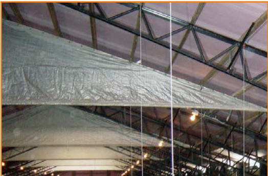
图 6.14：空气第一个挡风板/挡风帘在纵向通风的鸡舍中的位置示例。
