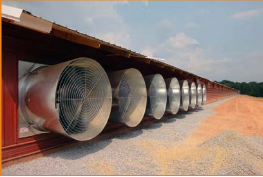
图 6.13：典型的纵向通风的鸡舍示例。
