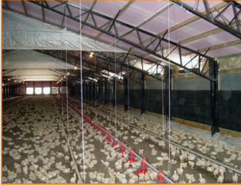
图 6.10: 过渡通风模式下鸡舍的内部视图。进风口完全打开，纵向风机正在运行。鸡只的分布情况表明它们感到舒服。
