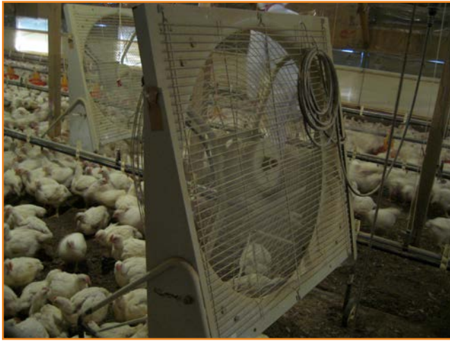
图 6.2: 自然通风的鸡舍中的循环风扇。
